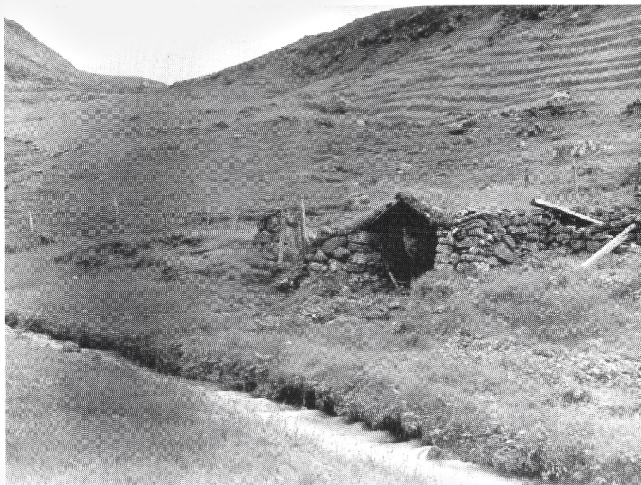
Fig. 25: Duegårdens bådehus, neyst , ved Skipás udløb i Pol-lur. Bådens stævn skimtes i åbningen.
